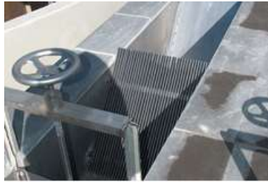
Figura VII.5. Rejas de limpieza manual. (Fuente: www.aquatreat.es/productos/desbaste.php ).
